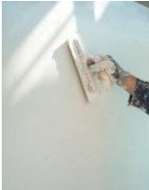
Fornitura e posa di un intonachino di finitura superficiale minerale fondamentalmente basato su silicati mono e bicalcici ed aggregati selezionati; elevata traspirabilità ed ottima adesione. Applicare con cazzuola o lama e finire con frattazzo o frattazzo spugna.
