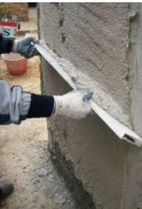
Su supporto precedentemente preparato, applicazione di sistema deumidificante anticondensa, antisale, ottenuto con la combinazione di diversi strati: il primo di regolarizzazione ed aggrappo (rinzaffo) avente uno spessore minimo di 5 mm avente le seguenti caratteristiche:
